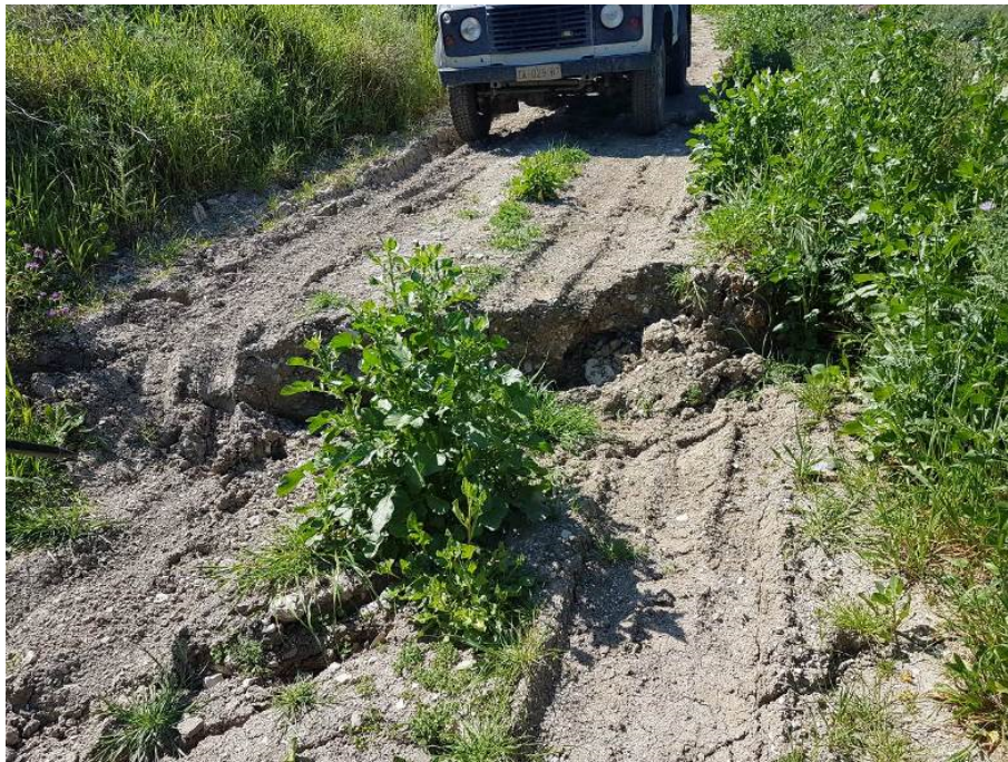
Figura 3 - Esempio di movimento del terreno presente lungo il tracciato della condotta;
